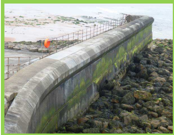
Pier wall (/4401C10)
